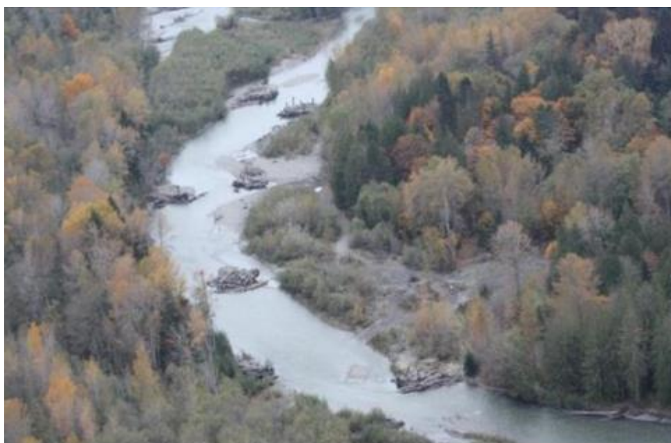
Figure 8 : Utilisation de bois mort pour la restauration écologique de la rivière Elwha dans l'Etat de Washington (Extrait du National Large Wood Manual)
