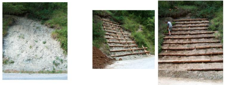
Fotos 7.3.a - Emparillado vivo: ante de la obra, durante y pasado un año (C. Crocetti)
