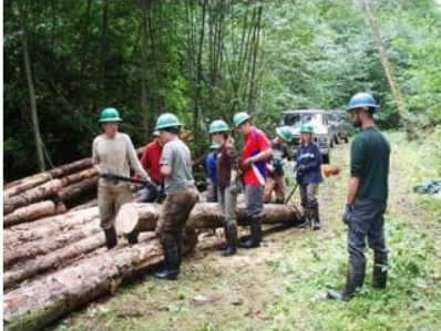
Placement du bois mort par la force humaine - Précision - Poids limité
