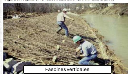
Figura 5. Entretejidos de taludes. Fuente: Manual de Bioingeniería (2013)
