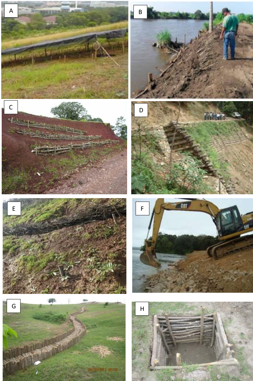
Figure 11 Photographies de quelques techniques mises en place en zone tropicale : A-plantation de pieux vivants sur talus en Malaisie (Mafian 2009) ; B-couches de branches en berge de cours d'eau au Guatemala (Petrone 2009 in Maxwald 2020) ; C- palissades sur talus au Nicaragua (Petrone et Preti 2010) :D-caissons végétalisés sur pente au Pakistan (Shah 2012) E-fascine de pente en Colombie ( Paz Zambrano 2022), F-enrochements végétalisés de pied de berge au Brésil (Holanda et al. 2021) ; G-tobogan végétalisé et H-caisse de dissipation en Colombie (Veraga 2019).
