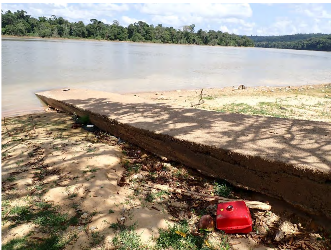
Figure 13 : Rampe de béton sur la berge de Boniville.
