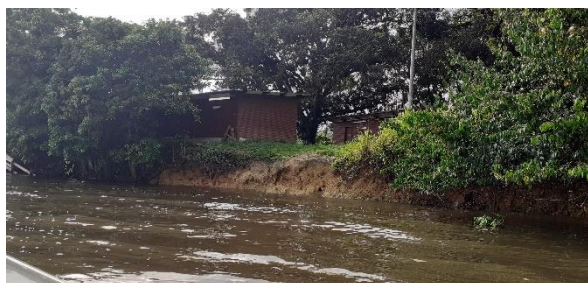
Figure 54 : Prise de vue du 26/07/2021 (PAG), Rôle protecteur de la végétation au niveau des bâtiments de la CTG et du carbet de déchets électroménagers
