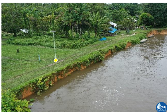
Figure 75 : Prise de vue drone (18/05/2022), village Alamilã (OEG, PAG)
