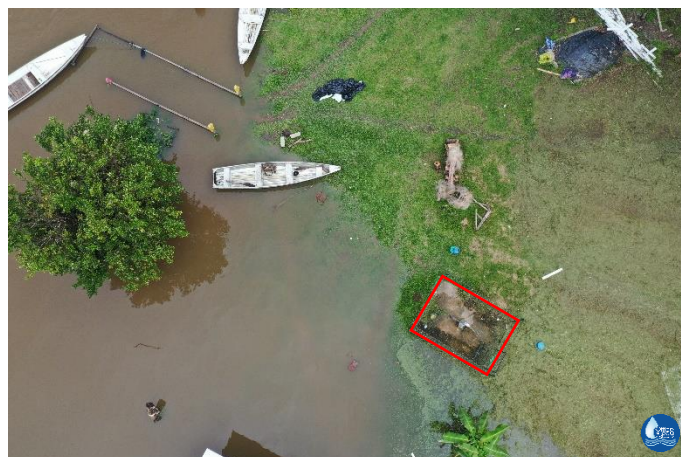
Figure 103 : Prises de vue (19/05/2022 – OEG/PAG), forage AEP, PMH Pina
