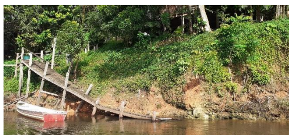
Figure 38 : Prise de vue du 20/07/2021 (PAG), dégrad sur l'Oyapock
