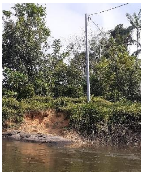
Figure 30 : Prise de vue du 26/07/2021, poteau électrique sur l'île diable, raccordant Ilet Mulat au bourg
