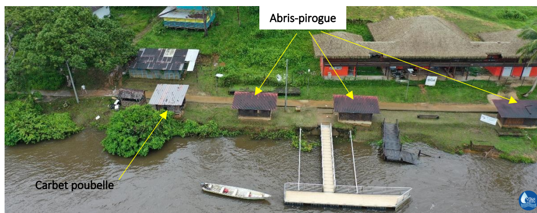
Figure 62 : Prise de vue drone du 16/05/2022 des carbets abri pour la pirogue scolaire et des carbets poubelles menacés par l'érosion
