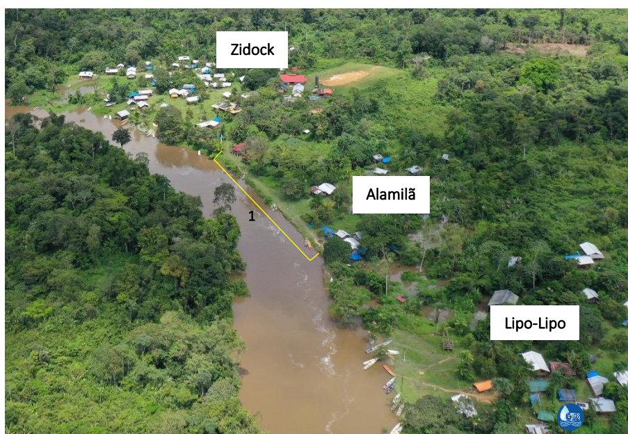
Figure 74 : Prise de vue drone (20/05/2022) du village Alamilã et localisation des photographies ci-dessous
