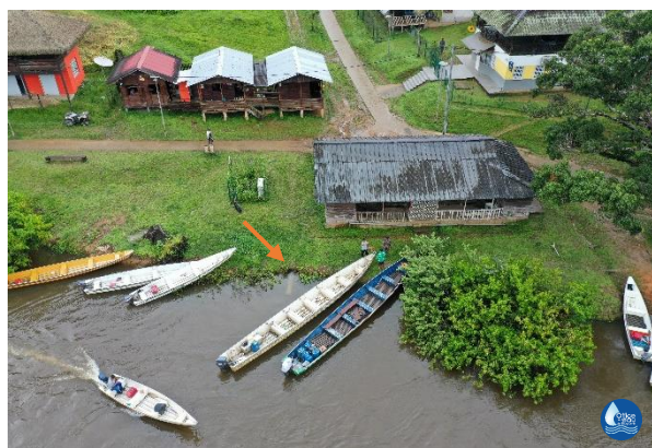
Figure 21 : Canalisation témoin du recul des berges, vulnérabilité d'un bâtiment privé, parking des pirogues, prise de vue aérienne, 16/05/2022 (OEG, PAG)
