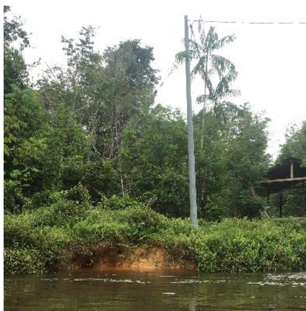
Figure 31 : Prise de vue du 16/05/2022, poteau électrique sur l'île diable, raccordant Ilet Mulat au bourg
