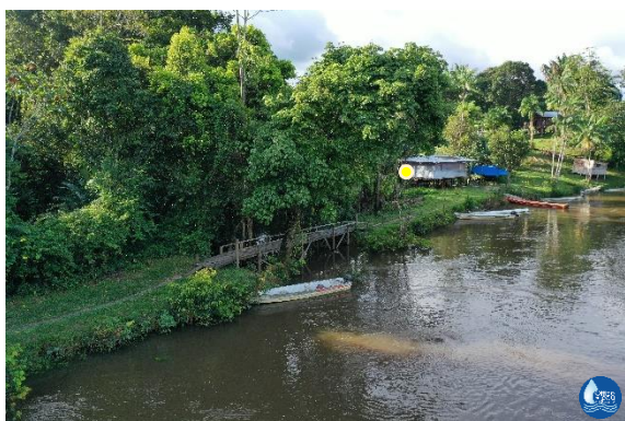
Figure 88 : Prise de vue drone (17/05/2022), passerelle reliant Lipo à Kalana (OEG, PAG)
