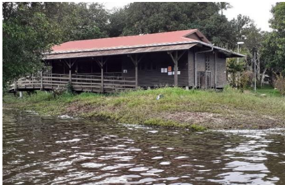
Figure 32 : Prise de vue du dispensaire en hautes eaux, 15/06/2021 (PAG)
