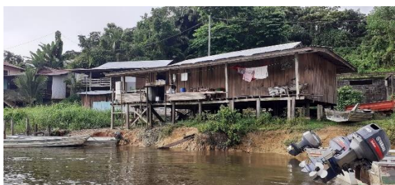
Figure 58 : Prise de vue du 21/07/2021 (PAG) bâtiment privé en amont de l'épicerie du bourg
