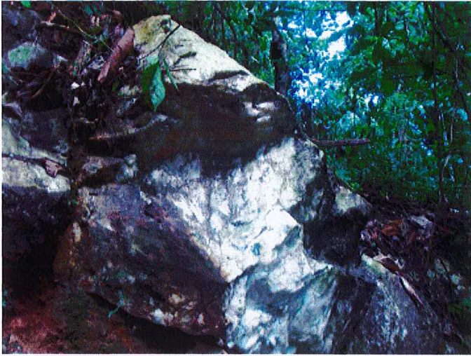
Figures de fracturations thermiques sur le front de taille de la fosse ouest de Bœuf Mort 3
