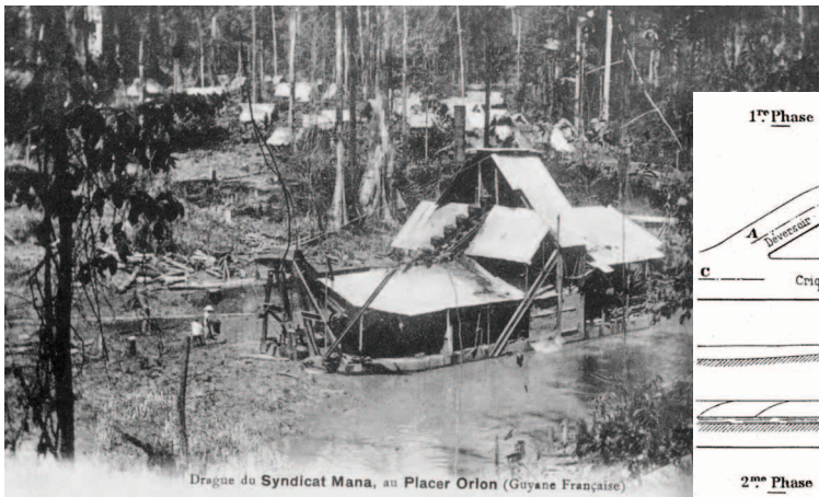
La drague Mana n°1 creusant le lit majeur marécageux du placer Orion, à proximité de la Crique Léopard en 1910. Elle entame ses travaux depuis un bassin de lancement établi au sein du lit majeur (Schéma in Delvaux, 1911a) à gauche). Cette drague est évoquée par Paul Samary, gouverneur de Guyane, dans La Vie Coloniale (1 er avril 1911) : « Quant à la drague du Syndicat Mana, elle est en utile fonctionnement. Cet outil qui pèse plus de 200 tonnes a été amené, par pièces détachées à plus de 180 kilomètres à l'intérieur des terres au moyen de simples canots. »
