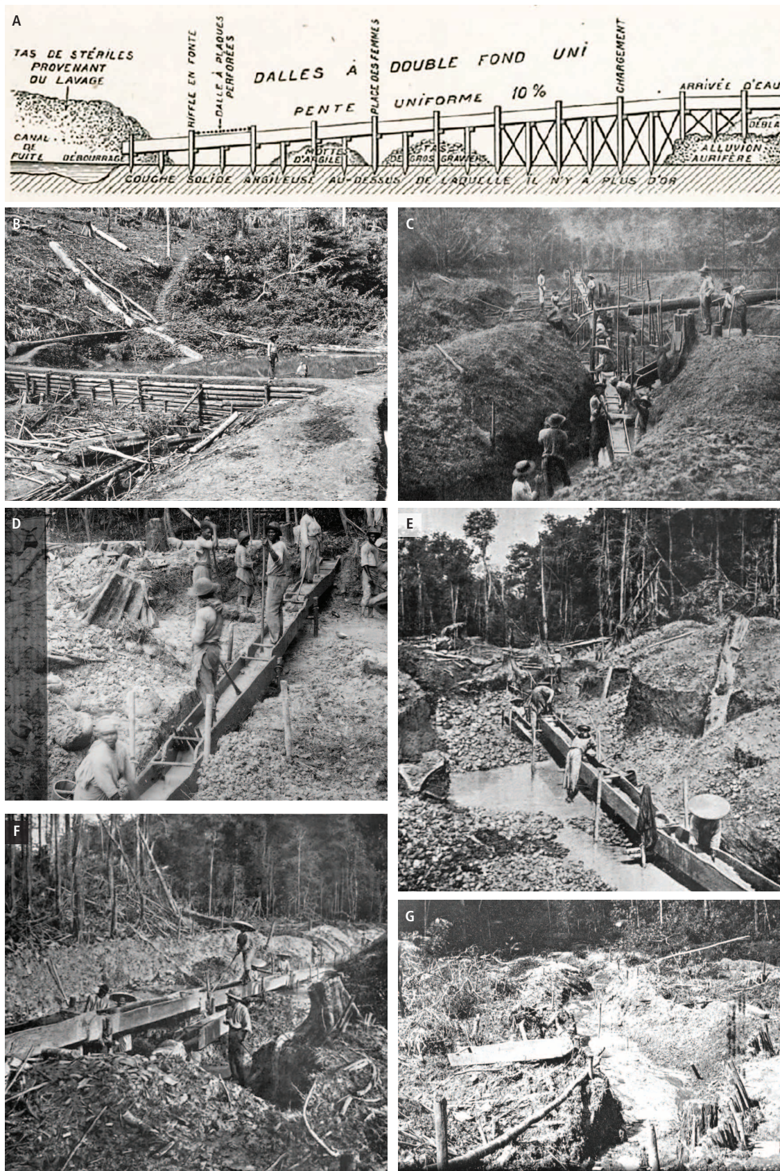
Coupe transversale illustrant le fonctionnement d'un sluice en Guyane à la fin du XIX e siècle (in Levat, 1898) (A). Exemple de barrage pour alimenter une prise d'eau sur le placer Saint-Élie (B). Sluice en fonctionnement sur le Placer Élysée (C). Sluice en fonctionnement sur la moyenne Mana (D). Débroubage manuel dans un sluice (E). Nettoyage du sluice en fin de journée (F). Fin de chantier sur une crique fraîchement orpaillée (G). (Photographies A. Molténi en 1883, J. Galmot en 1901 & M. Gachet en 1905 – source : BNF).
