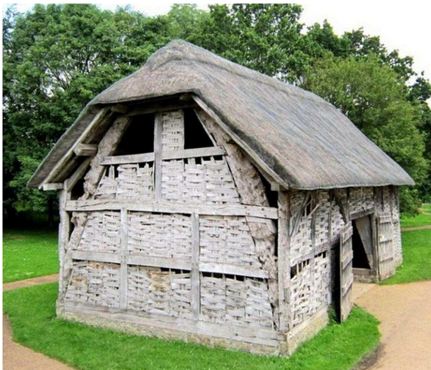
Fig. 10 – Grange à foin à pans de bois avec panneaux de clayonnage en lattes, dans le comté de Worcestershire, Angleterre.
