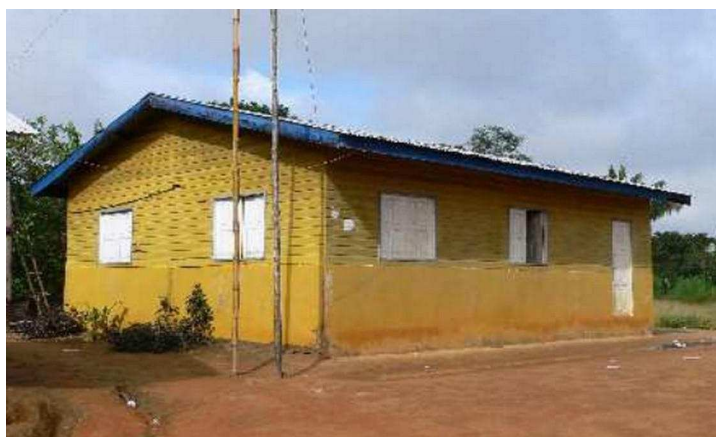
Fig. 17 – Maison mixte béton/gaulettes photographiée en 2012 au village Martin, à Saint-Georges de l'Oyapock. (Perez et Archambeau, 2012, p.120)
