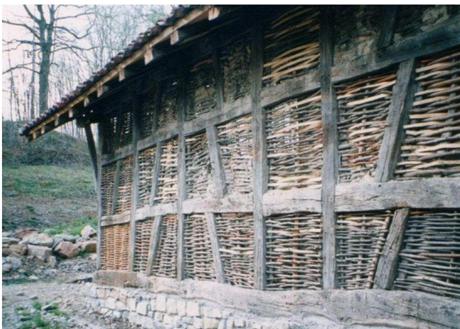
Fig. 9 – Maison traditionnelle de Bresse : le clayonnage (ici sur soubassements en pierre) constituait autrefois la technique la plus courante de remplissage des panneaux.
