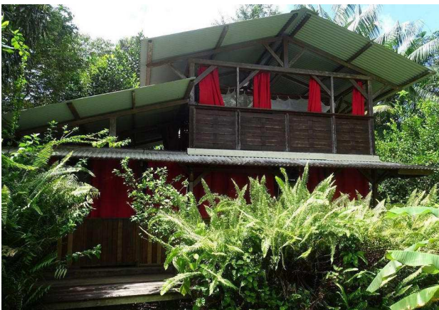
Le Relais du Fromager (hébergement touristique) ; panneaux de gaulettes tressés à partir de lamelles de bois gaulettes, mais également de lamelles de grignon sciées (bois non fendif).
