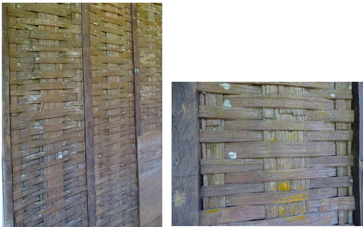
Fig. 2 – Panneaux de gaulettes tressées dans une ossature bois. (Gîte communal de Saül, Maison n°21 - cliché L. Clerc © Éveha, 2022)
