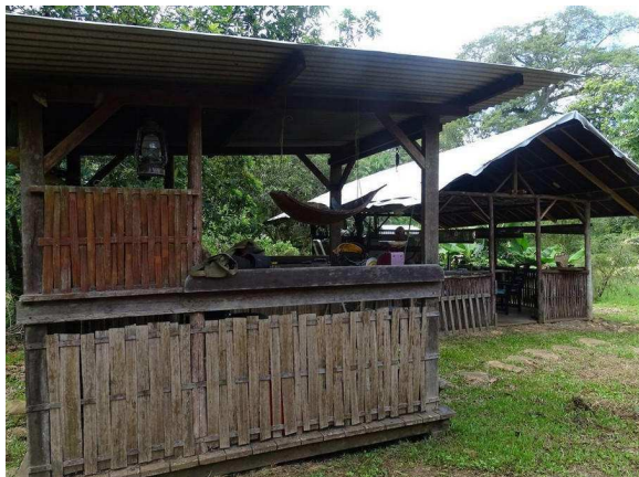
Chez Kami (hébergement touristique) ; panneaux de gaulettes tressés à partir de lamelles de bois gaulettes, mais également de lamelles de mahot cigare et mahot rouge (bois fendif).
