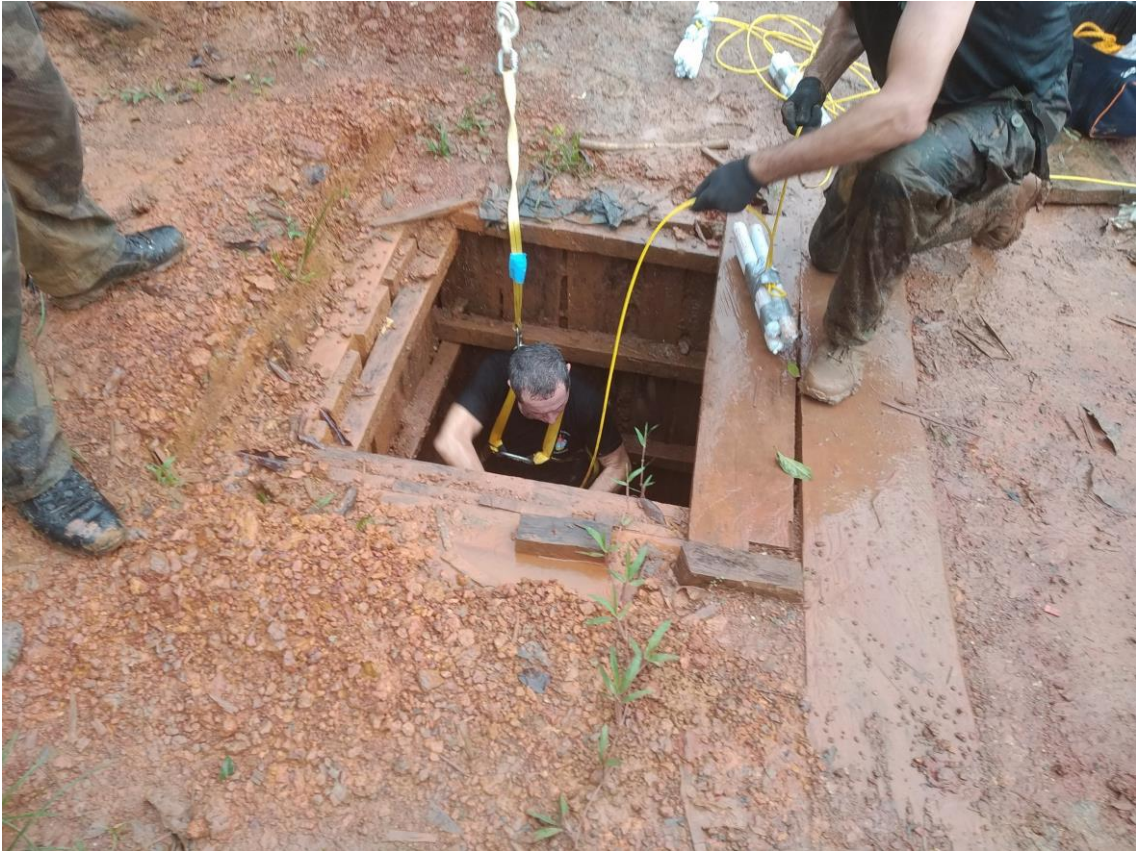
Installation des explosifs dans un puits clandestin.
