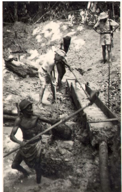
Pelle criminelle à long manche ; noter le tuyau d'alimentation du sluice, la sape (houe) et le crible à l'extrémité aval de la dalle.
