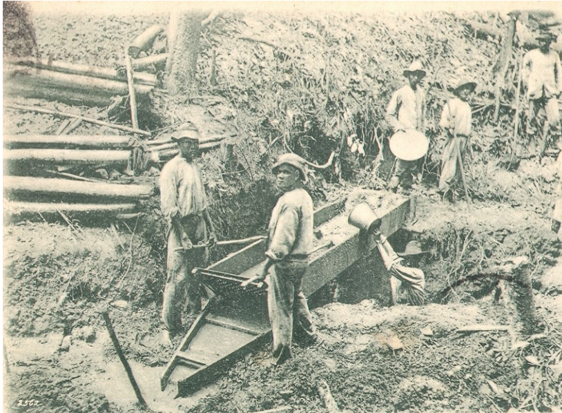
Épuisement des eaux d'une fosse à l'aide d'un seau métallique ; noter le sluice et le crible métallique. Carte postale ancienne, Suriname.
