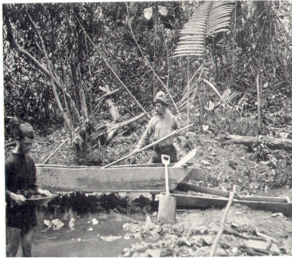
Pelle large à manche court pour le chargement du sluice dans les chantiers peu profonds.
