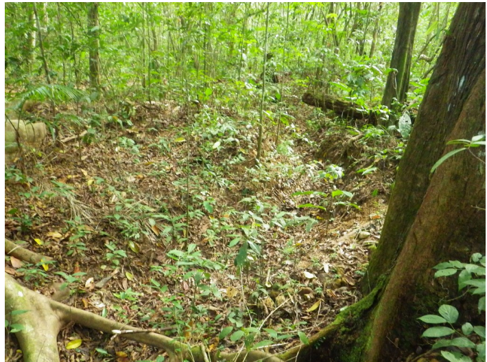
Canal d'amenée des eaux à flanc de versant vers le « Grand Fossé ».
