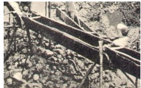
Détail de cartes postales anciennes illustrant les crochets-dalle en place pour soutenir le sluice.
