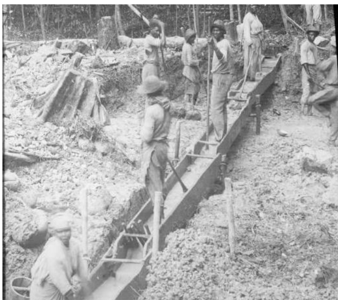
Travail à la sape dans le sluice pour faciliter l'écoulement des matériaux à laver ; photographie ancienne.
