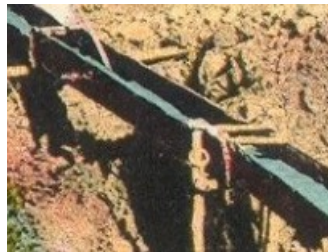
Détail de cartes postales anciennes illustrant les crochets-dalle en place pour soutenir le sluice.
