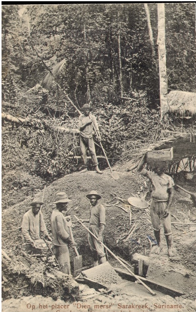
Différents outils de l'orpailleur : pelle criminelle à long manche, batée, sluice, crible, pelle large à manche court et sape ; carte postale ancienne, placer « Dieu Mersi », Suriname.
