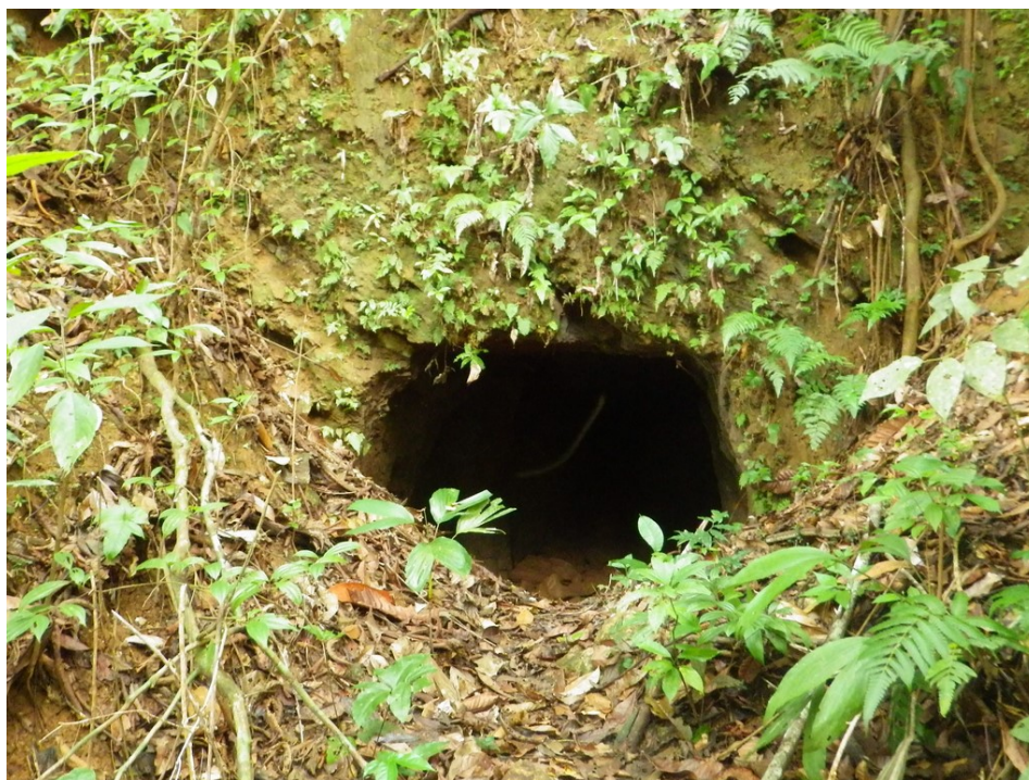
Galerie de recherche en bordure du layon de Bœuf-Mort, creusée à la main avec poudrière à gauche de son entrée ; travaux des années 50.
