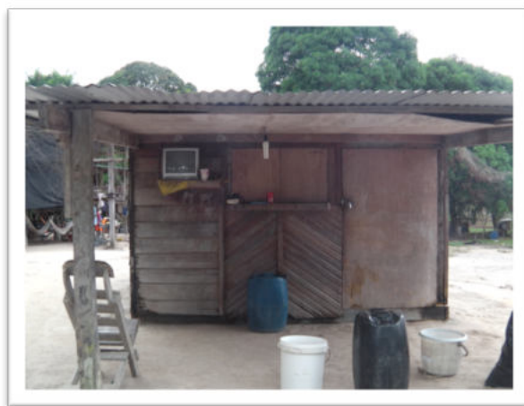
case fermée en bois et couverture tôle
