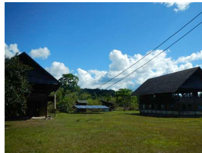
Ecole à droite et habitation des enseignants à gauche
